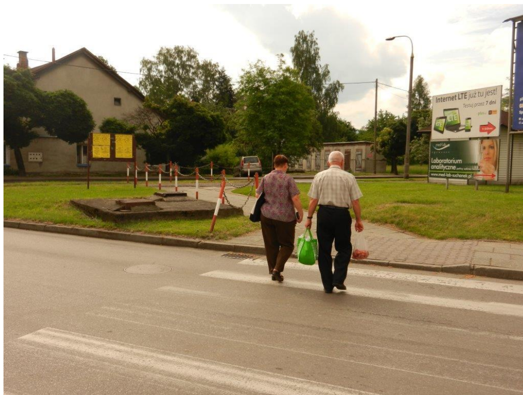
Wymagająca remontu ulica Górny Bór
