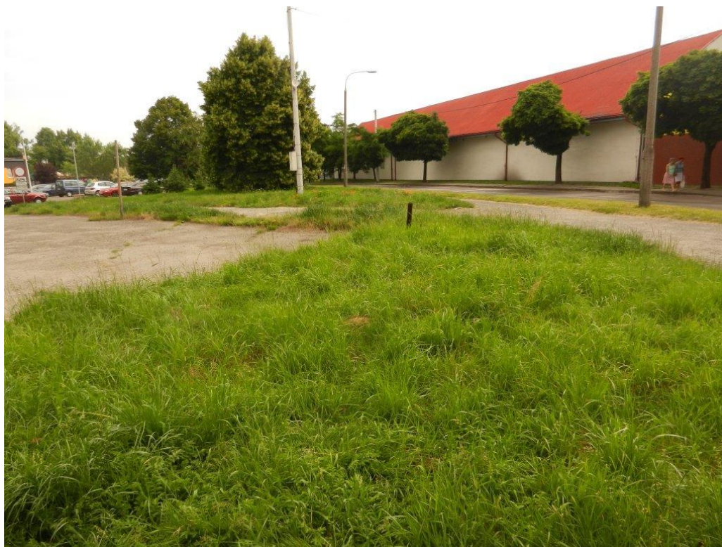
Wymagająca remontu ulica Górny Bór
