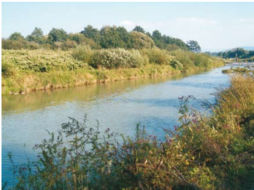
Wisła w Skoczowie – most kolejowy
