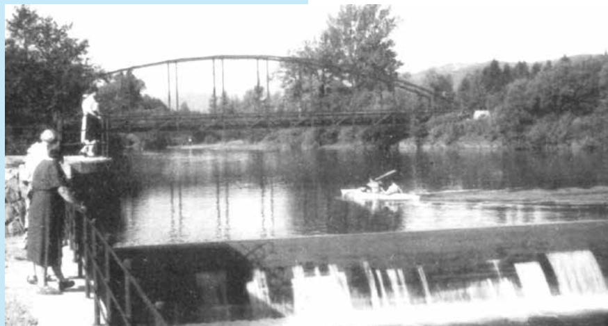
Most stalowy nad rzeką Wisłą z podwieszoną wodociągową rurą magistralną. (Reprodukcja fotografii Stanisława Szkawrana, Kalendarz Skoczowski, rok 2010 str. 93)
