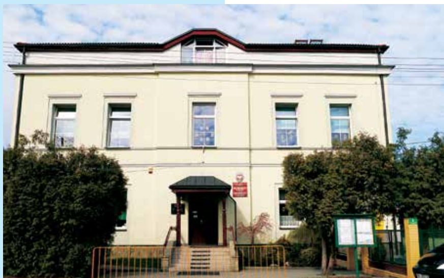
Przebudowa i modernizacja starego budynku szkoły
