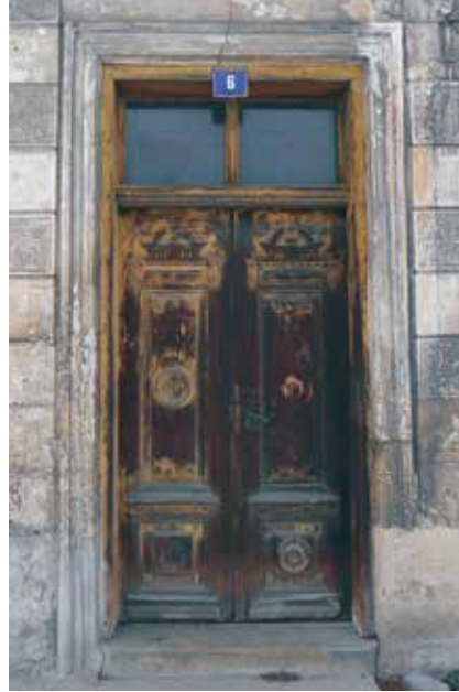
Drzwi wejściowe z naswietłem o walorach rzeźbiarskich
