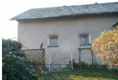
Fragment elewacji od strony ulicy
