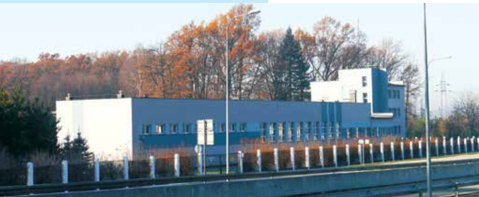
Widok ogólny z wiaduktu, rok 2012
