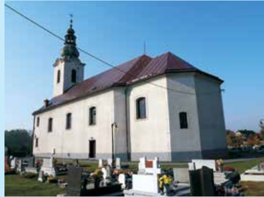
Elewacja tylna i boczna, południowa
