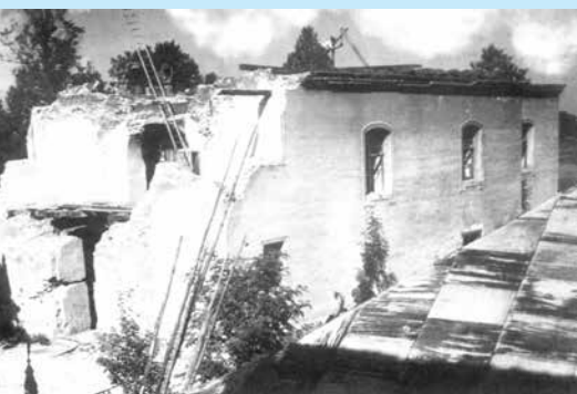
Główne wejście (jak wyżej)
