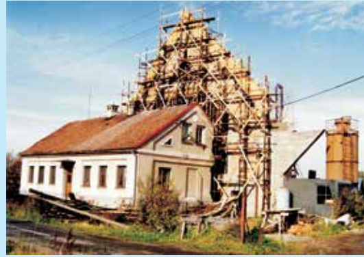
Budowa ściany czołowej kościoła
