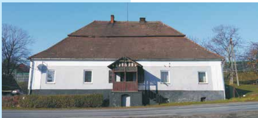
Elewacja główna, rok 2013
