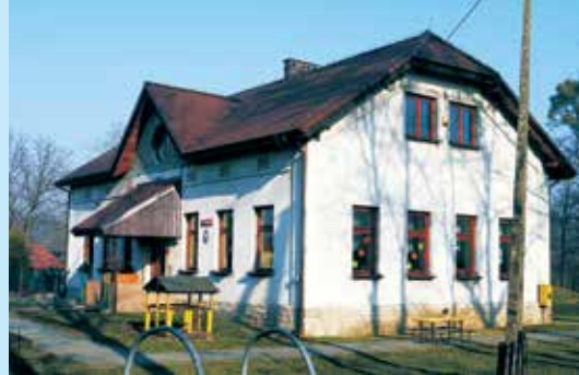
Przedszkole po przebudowie, w dawnym budynku szkoły
