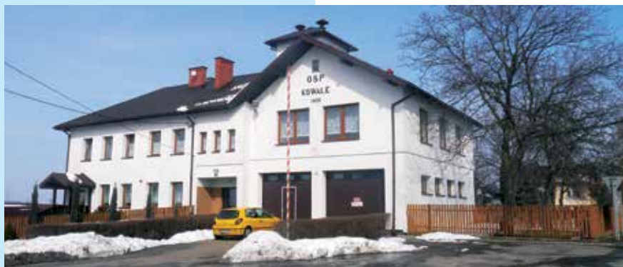
Widok ogólny budynku OSP
