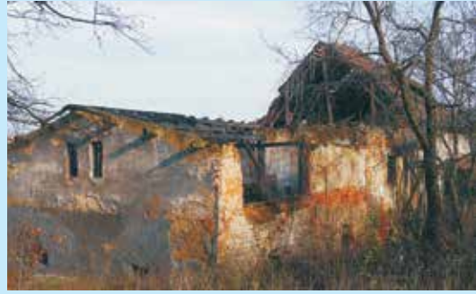
Widok od strony pł.-wsch.
