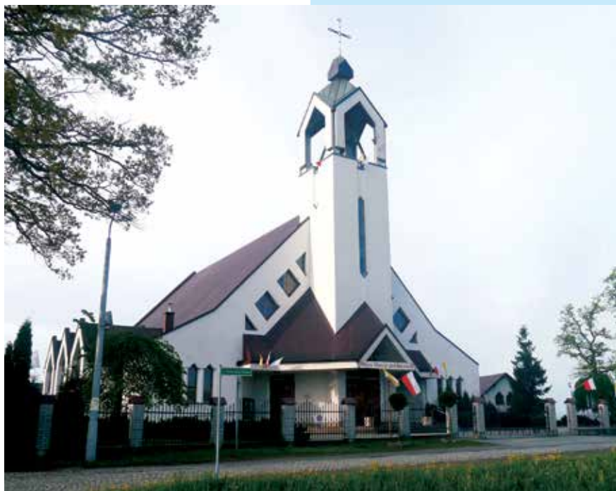
Kościół NMP w Pogórze, elewacja główna
