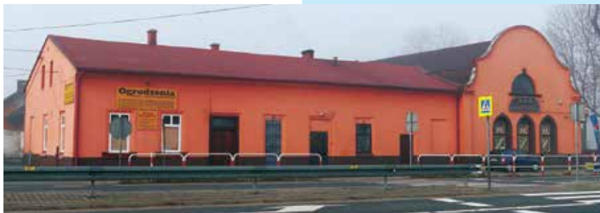
Współczesny widok głównej elewacji dawnej gospody
