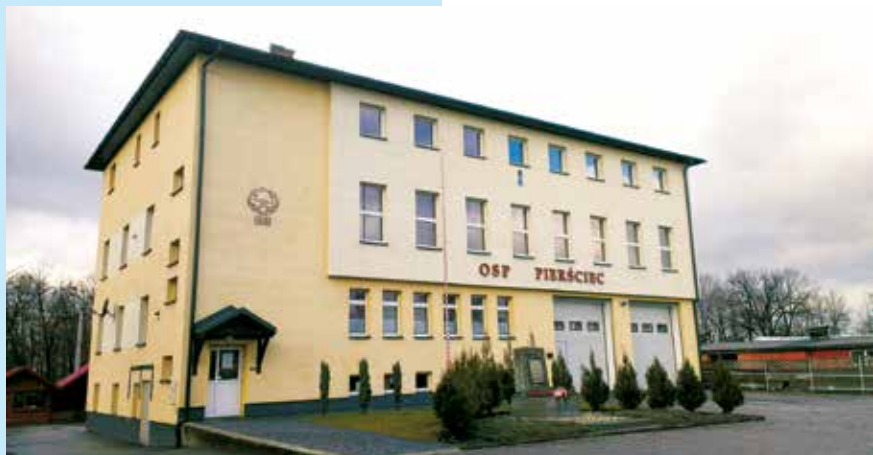
Elewacja główna budynku OSP
