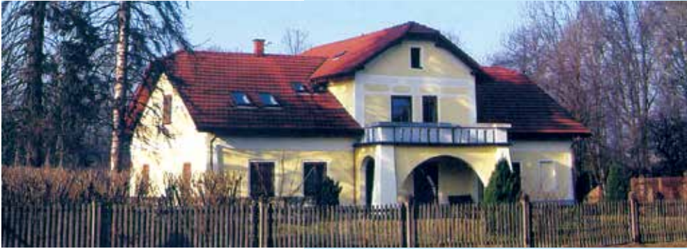
Budynek starej szkoły czynnej do 1905 roku, częściowo przebudowany, widok współczesny
