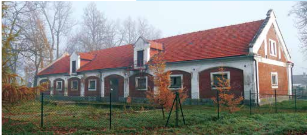
Kolejna stajnia Stadniny Koni, po renowacji budynku
