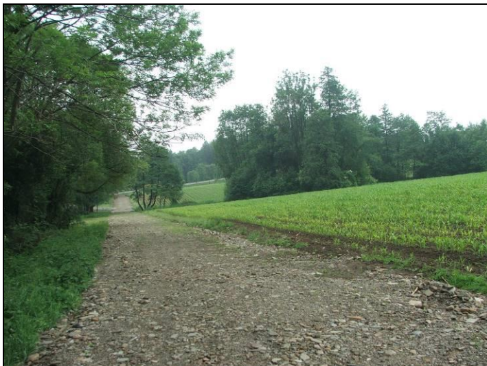
Fot. 2 Zrealizowana droga, widok w kierunku południowym, po stronie zachodniej teren 3MW
